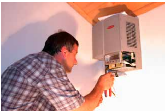
Montage Wechselrichter, Foto "die umweltberatung"
