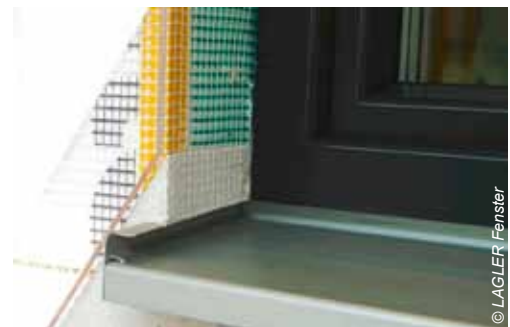
Dämmung der Fensterlaibung bei einer Wärmeschutzfassade
