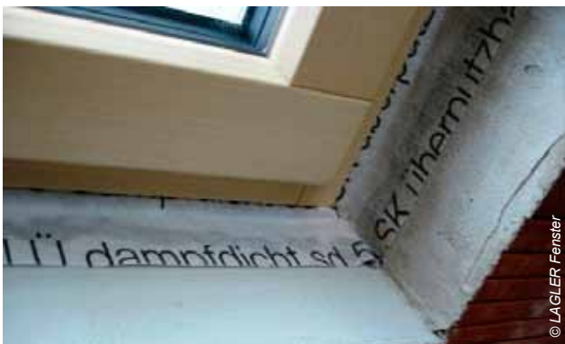
Luftdichter Einbau mit Glattstrich und Klebefolie
