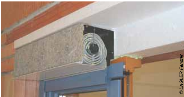
Wärmebrückenfreier Einbau eines Rollladens
