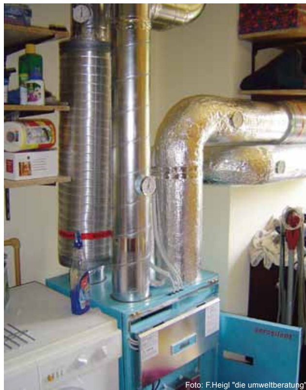
Eingebautes Lüftungsgerät einer Wohnraumlüftungsanlage mit Wärmerückgewinnung
