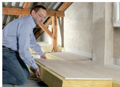
Verlegung von tragfähigen Dämmplatten
