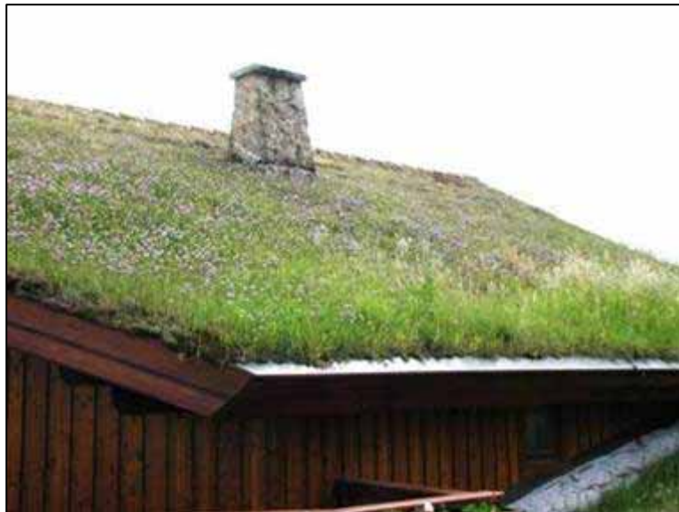
Foto 10: Extensiv begrüntes Dach mit wärmereduzierender bzw. kühlender Wirkung. © Jörg Fricke
