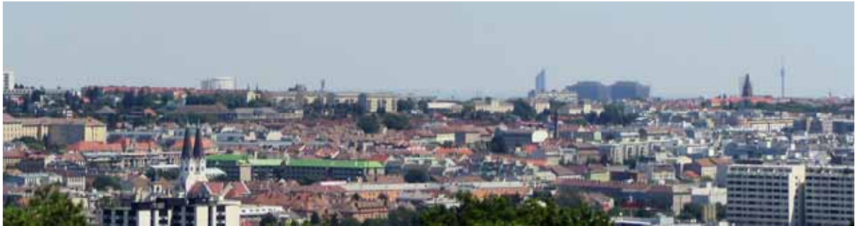
Foto 3: Dächerlandschaft über Wien. Über 5.022 ha projizierte Dachflächen bergen ein riesiges Potenzial für Dachbegrünungen. © Gerda Hüfing
