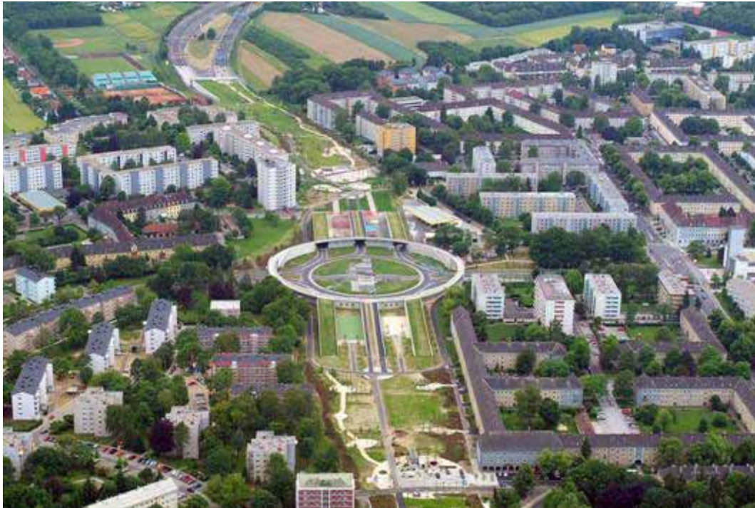
Foto 30: A7 Autobahneinhausung am Bindermichl in Linz. © Edmund Maurer, Stadt Linz
