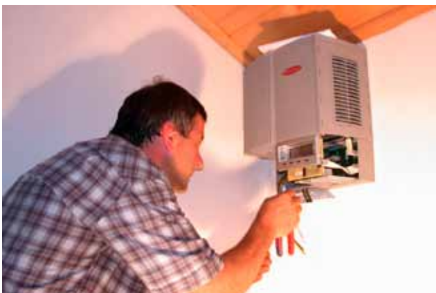
Montage Wechselrichter, Foto "die umweltberatung"
