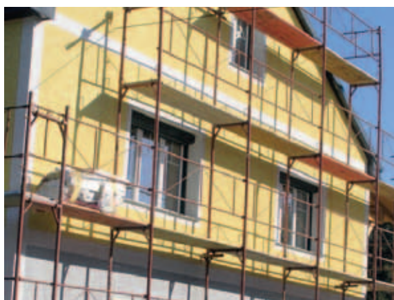
Außenwanddämmung reduziert Kesselleistung
