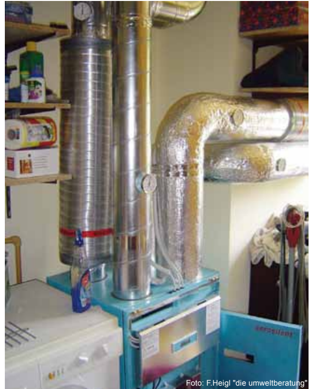
Eingebautes Lüftungsgerät einer Wohnraumlüftungsanlage mit Wärmerückgewinnung
