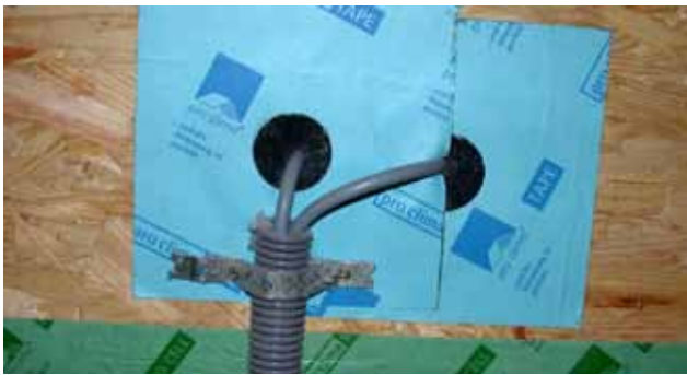
Luftdichte Rohrdurchführung
